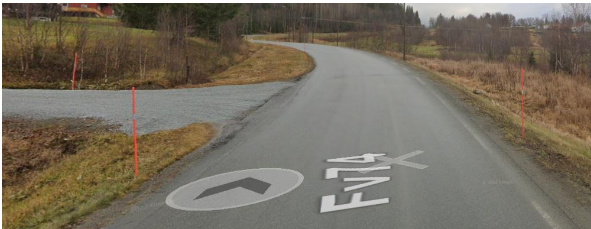
Figur 10. Viser avkjørsel nr. 11. Bildet under viser avkjørsel nr. 11 sett fra øst.
