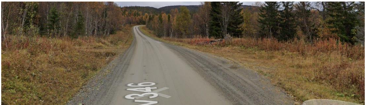
Figur 4. Østre avkjøring og parkeringslomme/møteplass sett fra vest.
