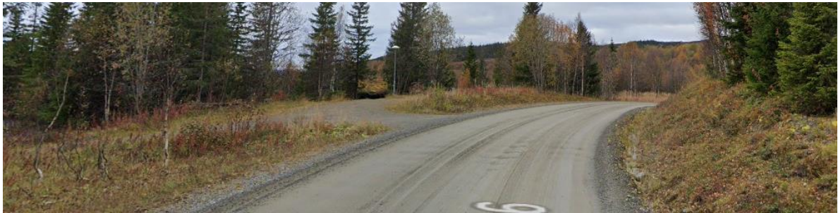
Figur 3. Vestre avkjøring sett fra øst.
